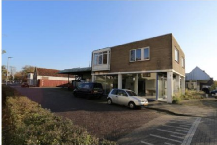
Figuur 1.3: foto bestaande bedrijfsbebouwing Ooststraat
