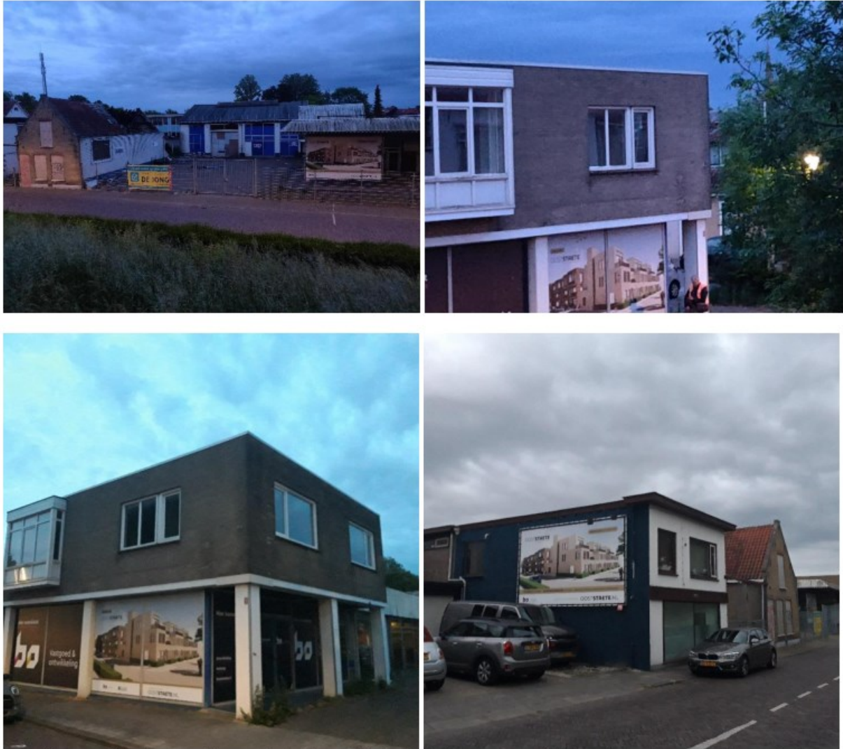
Figuur 2.2. Impressie van het plangebied. Linksboven: aanzicht op het plangebied vanaf de tegenover liggende Oostdijk; Rechtsboven en linksonder: kantoorgedeelte met spouwmuur en open stootvoegen; Rechtsonder: De te slopen gebouwen vanaf de Ooststraat in westelijke richting.
