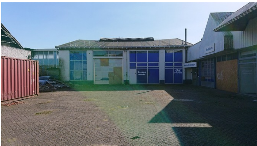
Zicht op de garage
