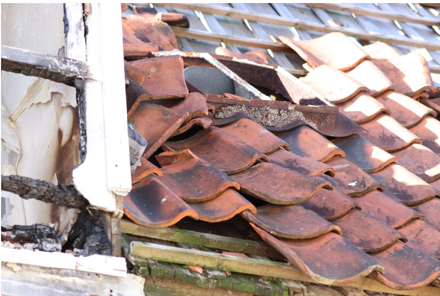
Afbeelding 6: Het door brand verwoeste woonhuis kan alsnog functioneren als nestplaats voor huismussen.
