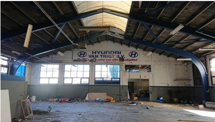
Binnenzijde voormalige garage
