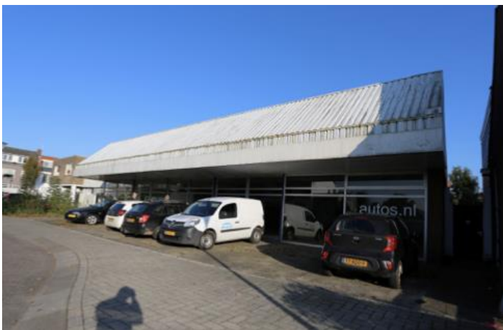
Figuur 1.4 foto bestaande bedrijfsbebouwing Prins Bernhardstraat
