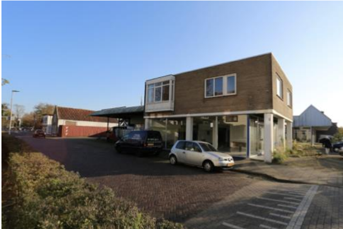
Figuur 1.3: foto bestaande bedrijfsbebouwing Ooststraat
