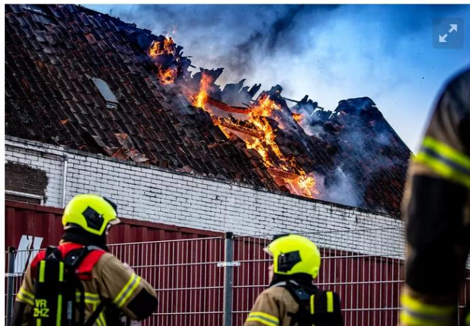
▲ Een grote brand in een woning aan de Ooststraat in het centrum van Oud-Beijerland vanmorgen. De brandweer liet het pand gecontroleerd uitbranden. © Jeffrey Groeneweg/Qphoto
