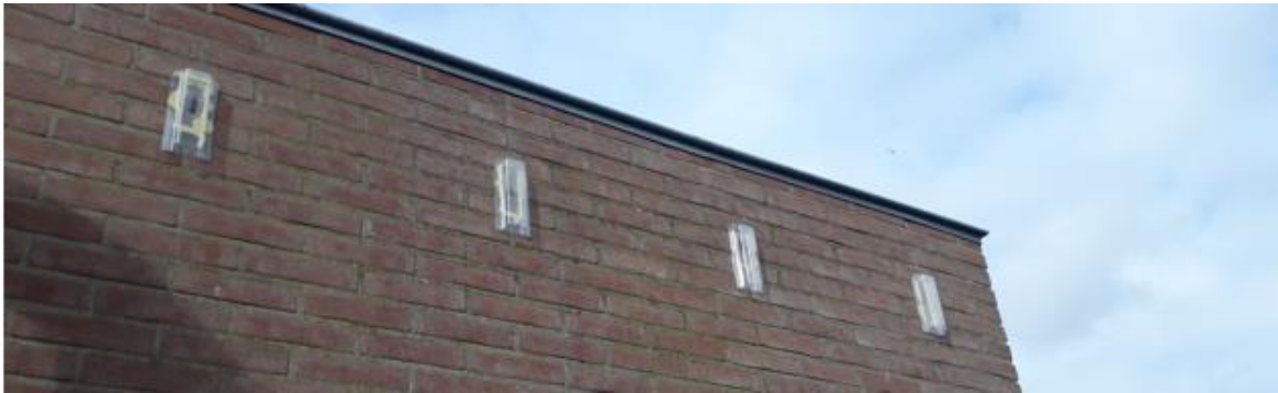
Figuur 4.5. Exclusion flaps voor open stootvoegen (© Aqua-Terra Nova BV).
