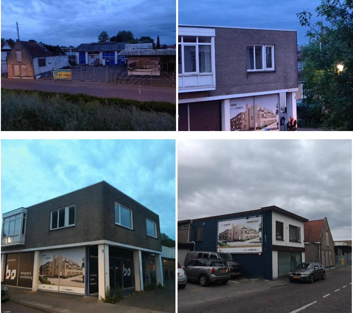
Figuur 2.2. Impressie van het plangebied. Linksboven: aanzicht op het plangebied vanaf de tegenover liggende Oostdijk; Rechtsboven en linksonder: kantoorgedeelte met spouwmuur en open stootvoegen; Rechtsonder: De te slopen gebouwen vanaf de Ooststraat in westelijke richting.
