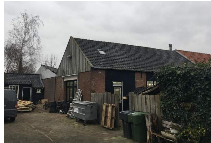
Figuur 3: Aanzicht werkplaats met schuifdeur (links) en deur (rechts)
