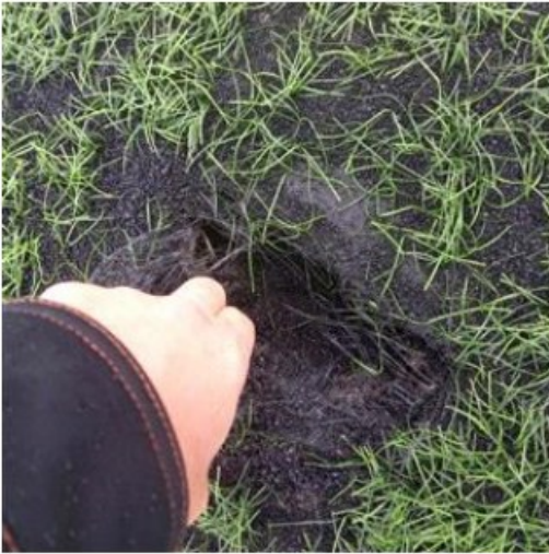
Gat in de toplaag
