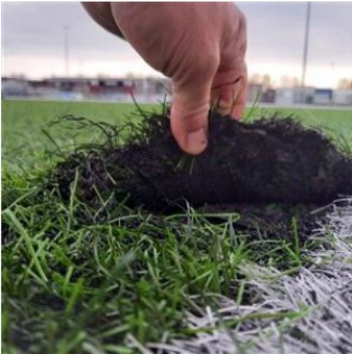
Onthechting van de toplaag Zuidzijde
