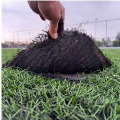
Onthechting van de toplaag Zuidzijde
