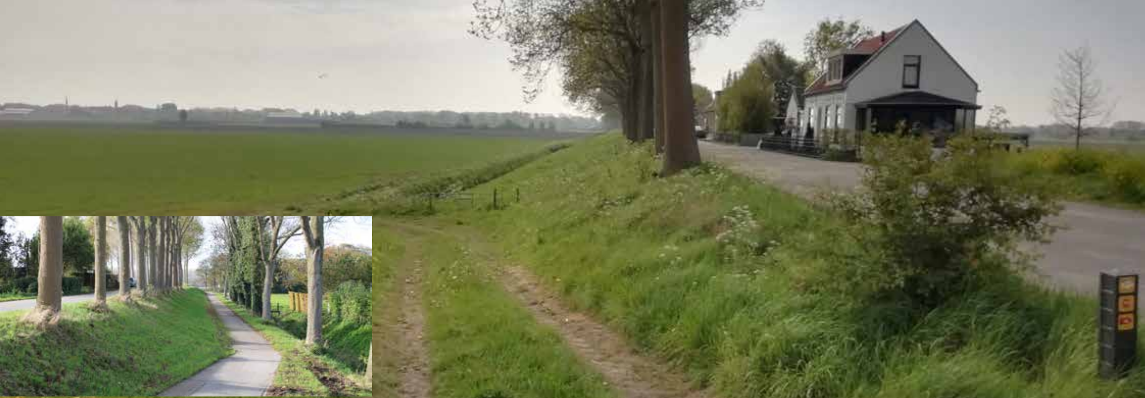
Afb 3.8 De Westdijk bij Mijnsheerenland vormt de westelijke begrenzing van de polder Mijnsheerenland van Moerkerken. Hier is tevens duidelijk te zien dat de dijk aan de buitenkant enigszins flauw afloopt, in tegenstelling tot de steile binnenzijde (inzet Schuringsedijk)
