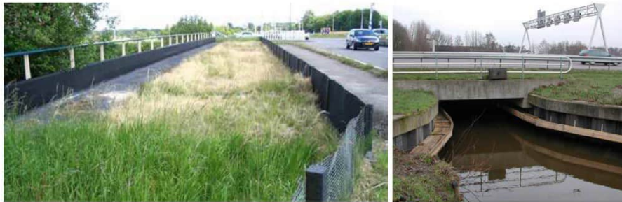
Figuur 22.3 Voorbeelden van infrastructuur met ruimte voor fauna (a) en een faunapassages bij een brug (b) (bron: Leidraad Faunavoorzieningen bij Infrastructuur)
