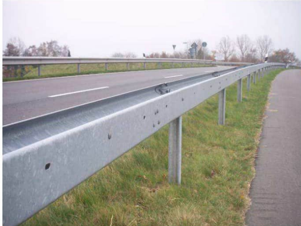
Figuur 10.7 Een praktijkvoorbeeld van een geleiderail met fietsersbeschermplaat tussen de hoofdrijbaan en het (brom)fietspad
