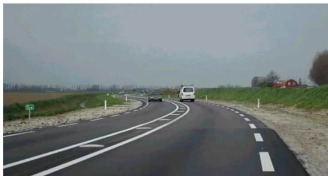
Figuur 4.11 Voorkeursoplossing rijrichtingscheiding GOW type 2, bij voorkeur schuingeplaatste broodjes (bron website CROW)
