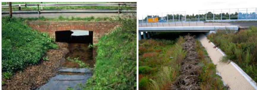
Figuur 22.2 Voorbeeld van geleidstructuren, richting en door een faunapassage. Een oever en vegetatie rand en een stobbenwand. (bron Leidr. Faunavoorzieningen bij Infrastructuur)
