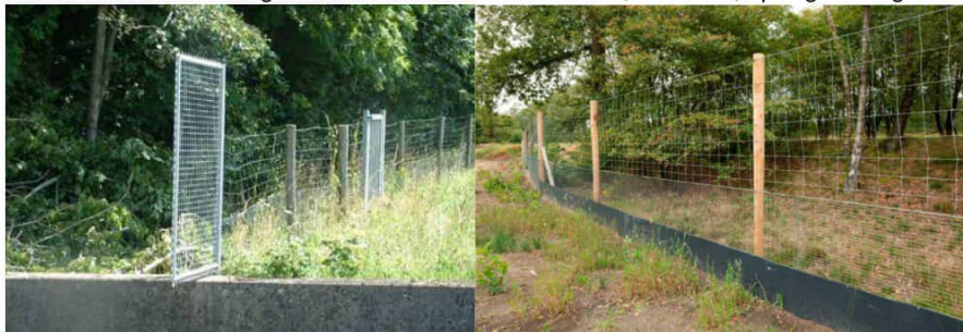
Figuur 22.5 Voorbeelden van een raster om fauna te keren met verlenging, zodat dieren niet om het raster heen kunnen en verschillende maasdiktes voor verschillende soorten. (bron: Leidraad Faunavoorzieningen bij Infrastructuur)
