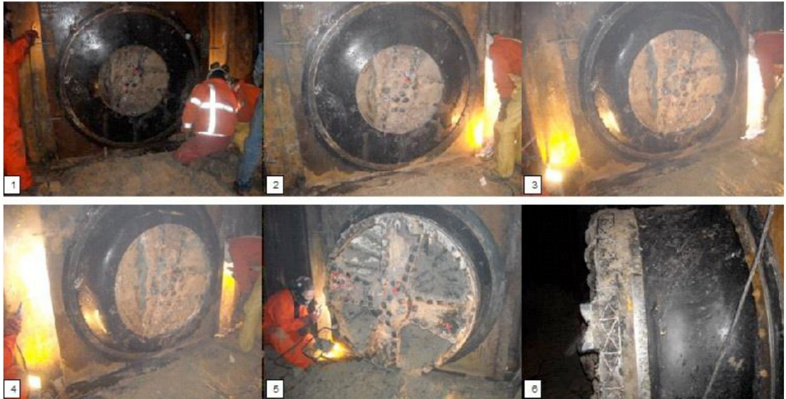
Figuur 6: Doorvoering boorkop door manchetrubber ontvangtzijde
