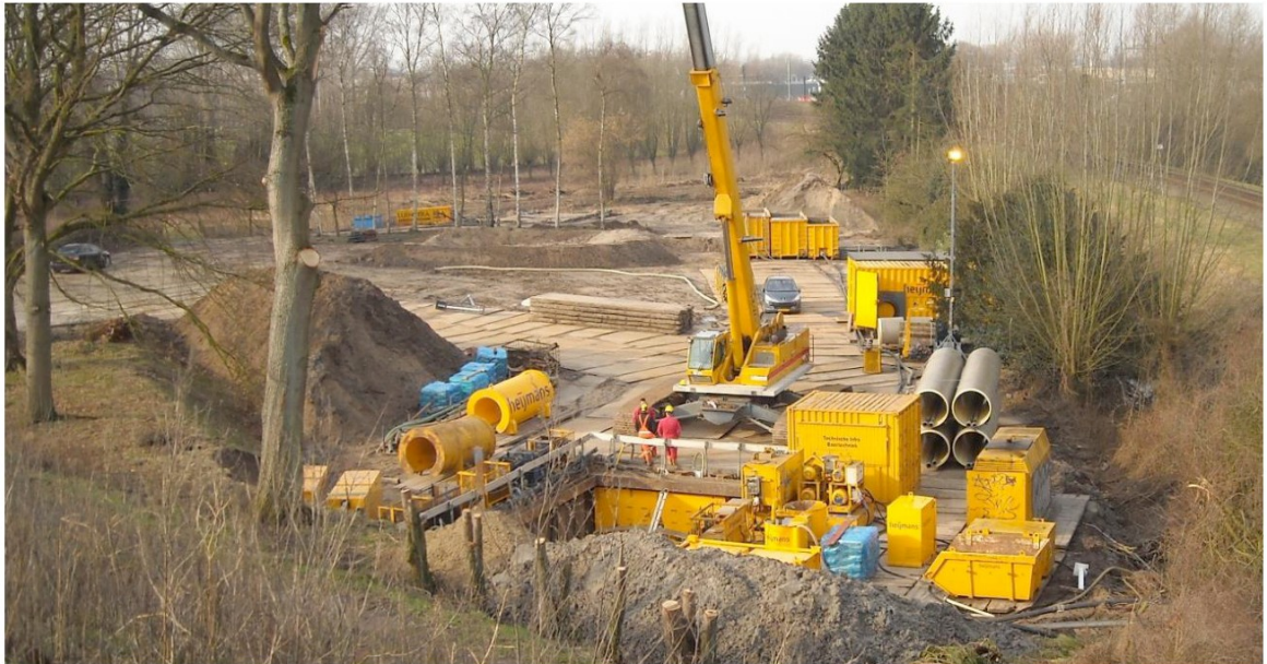
Figuur 2: Foto werkerterrein perszijde gesloten front boring incl. equipment
