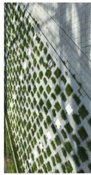
Perceerplaatsen in een openverharding
