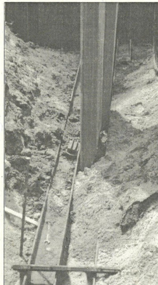
Een voorbeeld van waar de moeilijkheden ontstonden bij het plaatsen van de damwandplaten: een oude fundering (foto J )
