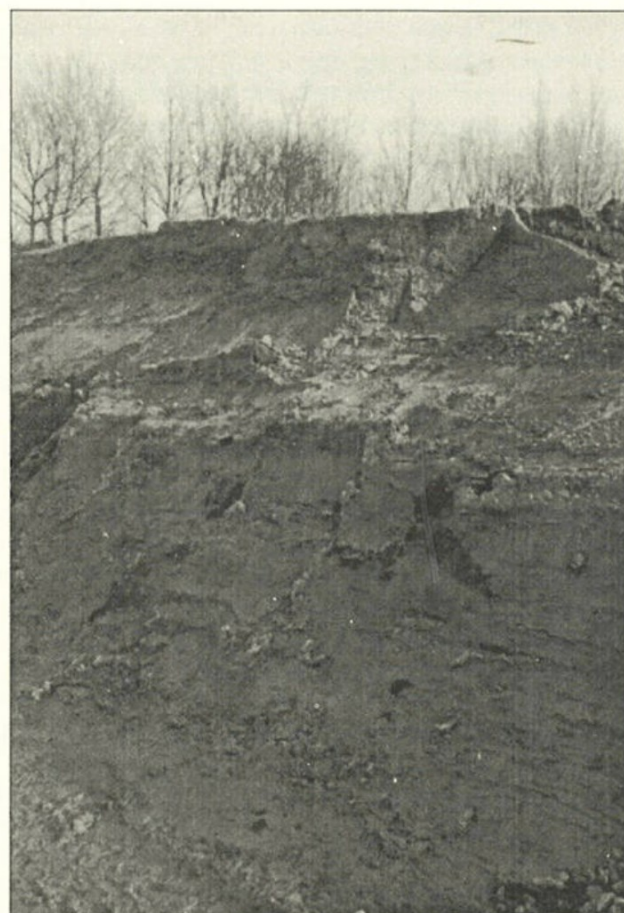
Opname van de putwand in de bodemsanering in Schuilingen. De bovenste bodemlaag bestaat uit lichtbruine klei, de onderste uit grijze klei met zand (foto: ).
